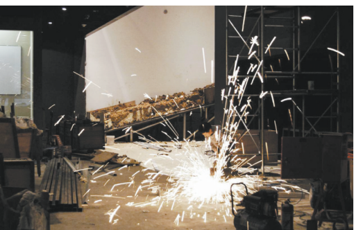
安装配套设施
