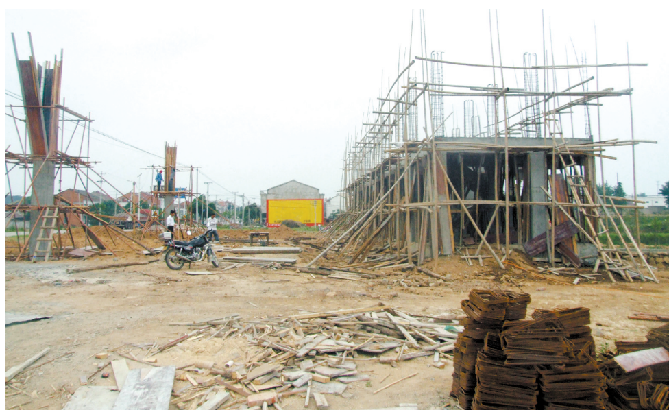
工程已完成大半
