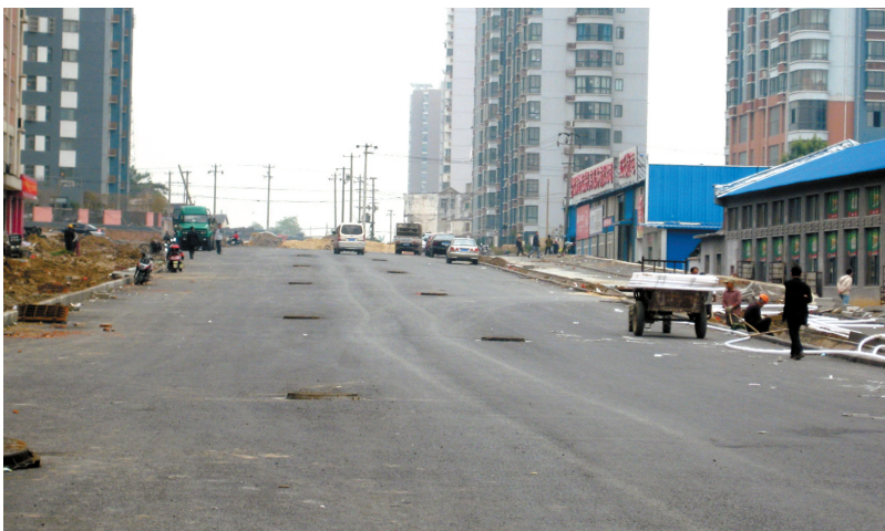
东段路面基层已铺了沥青
