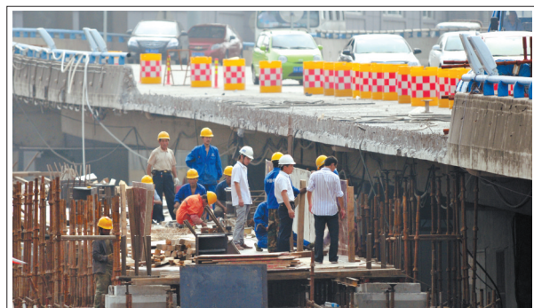
昨日,记者在合肥市金寨路高架与南一环交叉口看到,金寨路高架SE匝道(由南向东)已建成部分桥墩钢梁,而由东向南方向高架也已移除部分护栏,为今后的匝道建设提前做好准备了。待新建匝道完工,将有效缓解金寨路高架“上桥易下桥难”的状况。 记者 黄洋洋 文/图
