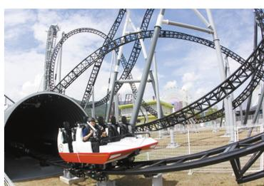
近日，日本大型游乐场富士急HighLand新建的名为“高飞车”过山车，获得世界吉尼斯证书，为世界最大角度过山车。“高飞车”全程1000米，最快速度可达100公里，在垂直上升到43米高的塔上之后，以121度的角度坠落，途中还有7处地方会在黑暗中进行。该大型过山车计划将在7月16日开放运行。 星报综合
