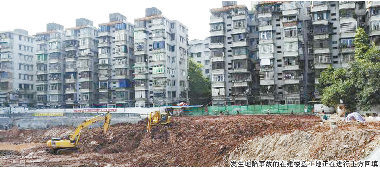
发生地陷事故的在建楼盘工地正在进行土方回填
