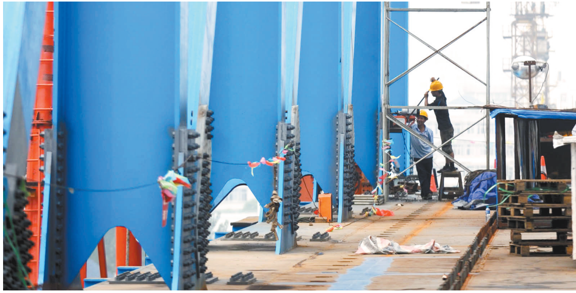
8月1日，施工人员在合肥南环线工地上对正在拼装的工程进行螺栓加固。为强化安全生产管理，合肥南环线改变过去计划工期施工模式，坚持质量安全第一，在合理工期安全生产的前提下完成工程建设。 新华社
