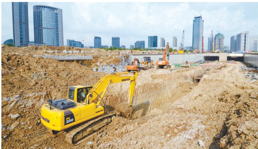
8月7日,合肥南二环路新市府广场前,一辆工程车正在对原有的下穿桥侧桩进行拆除拓宽,这也标志着“畅通二环”工程进入最重要的施工阶段。据了解,目前正在施工的市府广场辅道隧道工程,西起华南路,东至正阳南路,下穿市政府南侧广场,共计双向六车道,建成后的隧道上层依旧为市府广场,整个主体工程预计11月初完工。 记者 程兆/图
