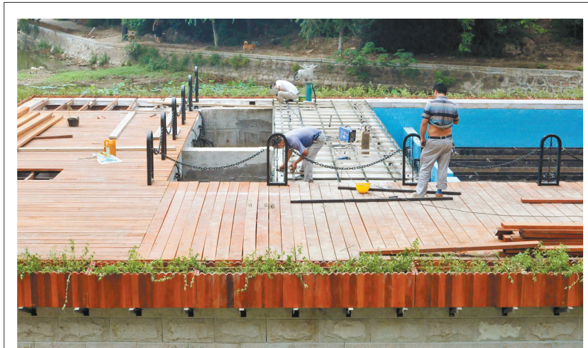
昨日,记者在合肥市包河污水处理站看到,之前因影响包河景区景观而被拆除的净化池库房正在重新进行装饰施工。木制装饰材料和绿色植物的点缀使得整个工程较好地融入了周围环境。 记者 黄洋洋文/图
