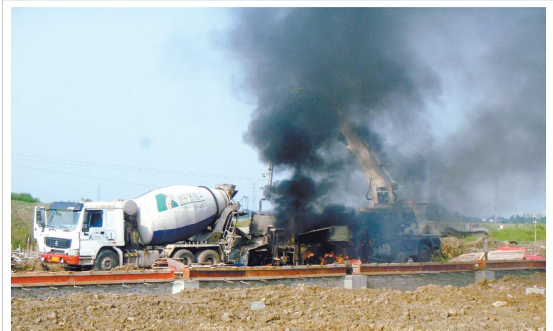
8月14日7时35分许,芜湖市清水镇一建筑工地内浓烟滚滚,一辆水泥浇灌车作业时因操作不当,浇灌臂碰上高压电线引发火情。接到报警后,芜湖消防部门迅速出击,在切断高压电源后,数分钟内就扑灭了大火,但是水泥浇灌车因火势凶猛,车体几乎烧成了废铁。
