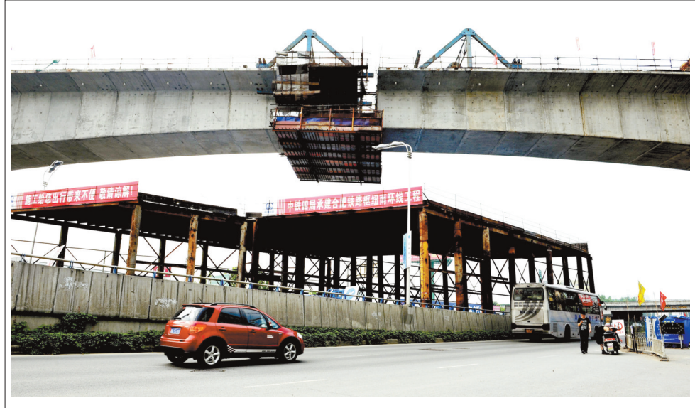
日前,历时一年多的合肥枢纽南环线、跨金寨路悬灌连续梁工程即将合龙。跨金寨路悬灌连续梁位于经开区特大桥116#-119#墩,总长203米,主跨90米。施工现场车辆、行人川流不息,在挂篮设置防护的同时,又在高架桥上方搭建了棚架,实行双层安全防护。 倪路 文/图
