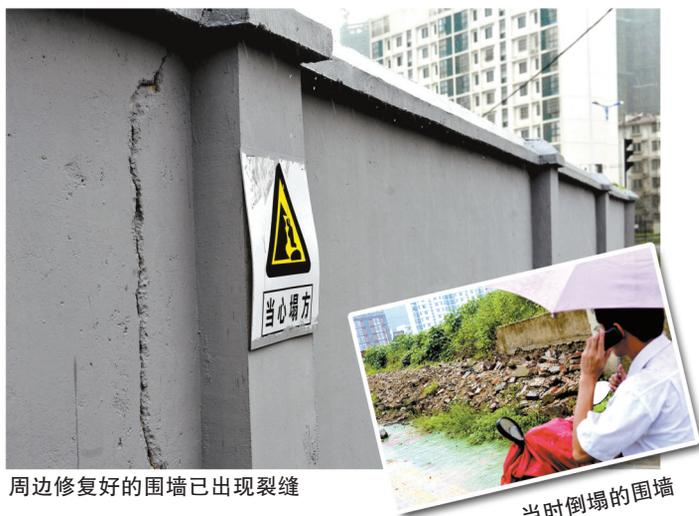
周边修复好的围墙已出现裂缝
