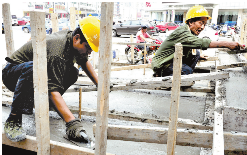
日前,合肥重点工程畅通一环(临淮路至淮南铁路段)施工现场,工人们在为人行天桥桥墩浇灌混凝土。该路目前已实施交通全封闭,11月份放行。 倪路/摄
