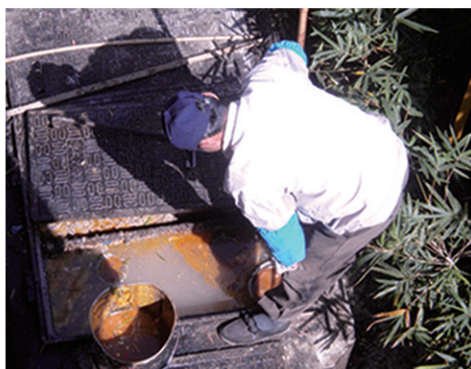
一名工人正在下水道捞油
