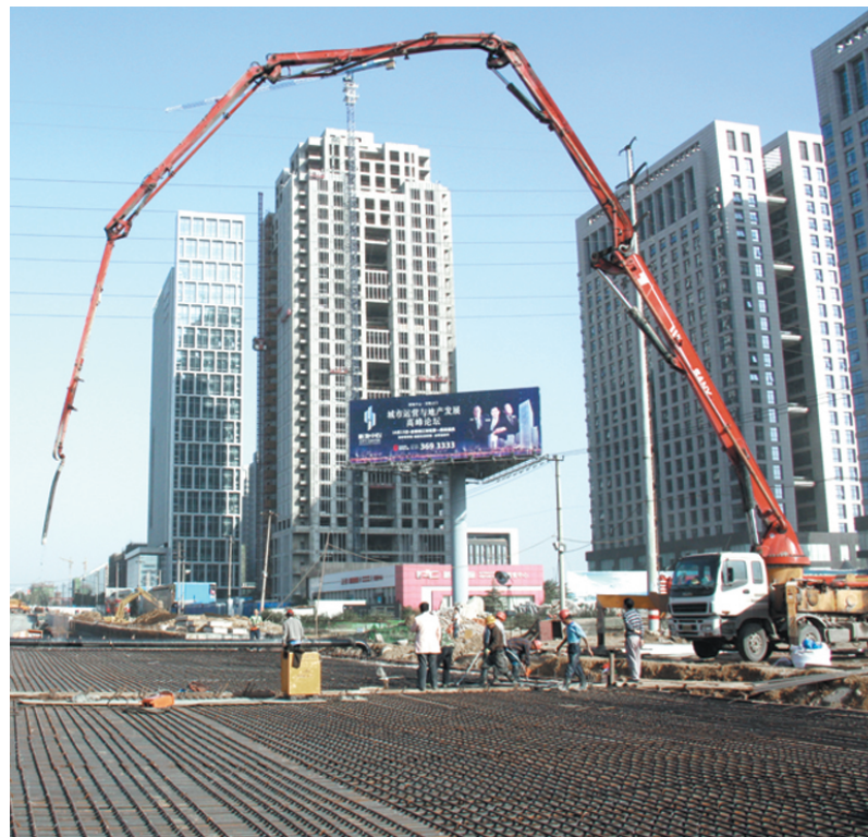
施工人员正在实施桥面作业
