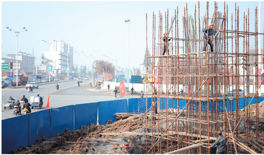
徽州大道与南二环路交口,工人正在搭建桥墩支架
