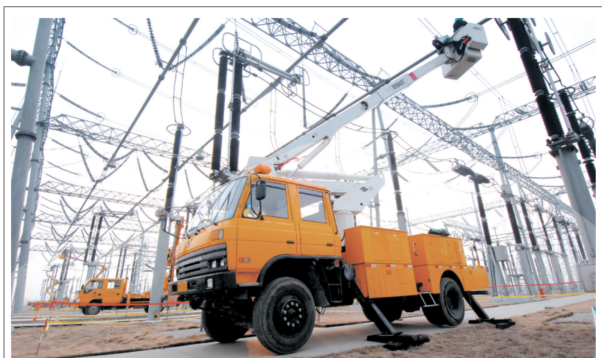
12月19日,省电力公司组织淮南、合肥、阜阳、蚌埠、六安5市供电检修工人对“皖东送”西通道起点工程500千伏淮南汤庄变电站进行首次跨地区联合检修,将原计划10多天的工作任务缩至2天完成,满足长三角地区度冬供电需求。陈彬 记者 圣林 文/图
