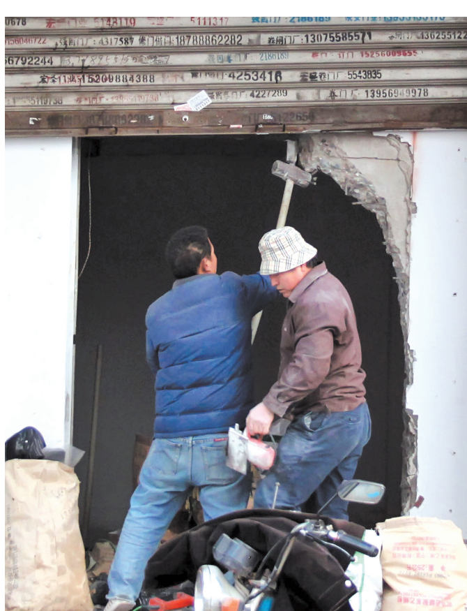
被拆的墙是不是承重墙,要是有问题他负责。记者离开时,规划拆掉的墙还剩一个拐角,男子说不拆了。
