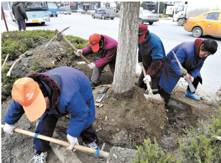
日前,合肥阜阳路高架桥前期工作全面展开,房屋的拆除,树木的移植等工程在有序进行。阜阳路高架南起沿河路,北至东方大道,全程9.3公里,是目前合肥最长的高架。
