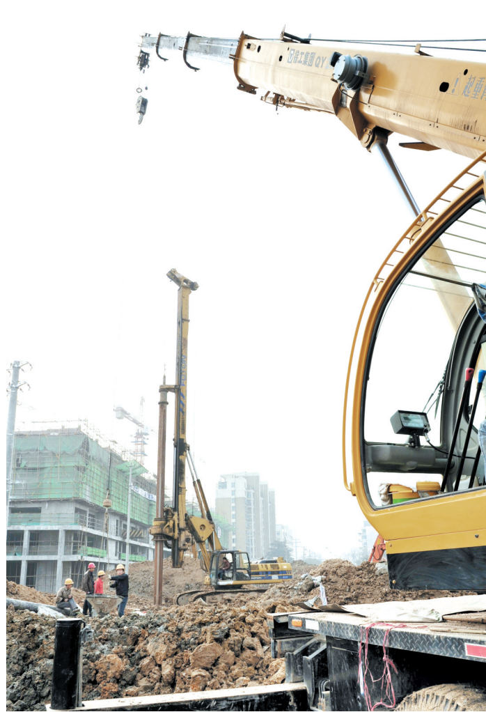
图为施工现场
