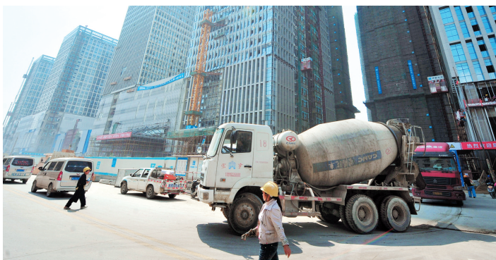
福建泉州某重点建设工程的土方车、水泥运输车
