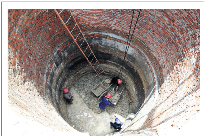
一年一度的汛期到来之际,合肥市对去年的老旧小区、道路内涝点及防汛排涝设施进行改造。昨日,记者在蒙城北路看到,施工人员正在井下作业,使路两旁小区的地下管道连接,保障今年汛期不再受水灾。
