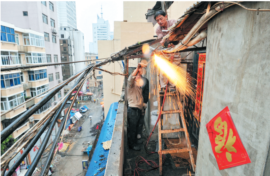
施工人员正在安装新雨棚
