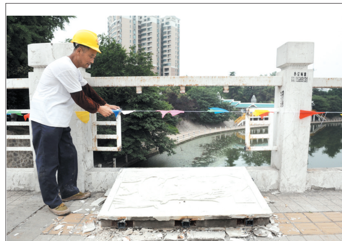
昨日上午,工人开始对长江路桥的围栏进行拆除。由于长江路桥的通行能力一般,结合近期开工的轨道交通一号线和胜利路畅通工程,这座始建于1973年的桥梁正式开始拆除重建。 记者 黄洋洋/图
