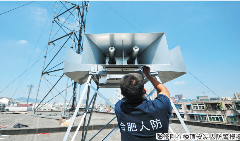
张修刚在楼顶安装人防警报器
