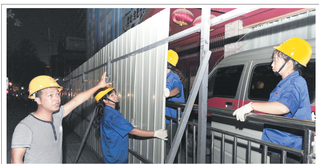
今日零时起,根据合肥市胜利路畅通工程及轨道交通1号线工程同步建设需要,胜利路段(站前路-寿春路)开始全封闭施工。施工单位有关负责人提醒广大市民,临泉路东西方向和凤阳路(一环)上跨桥以及寿春路东西方向施工先期均保持通行,其他交口采取全封闭施工。 记者 徐涛/文 倪路/图
