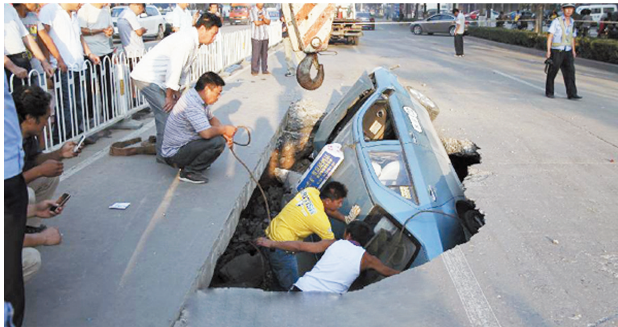
邯郸街头路面塌陷,出租车坠入坑中
