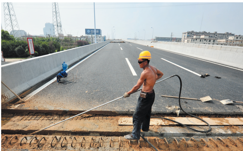
工人正清理徽高架路面伸缩缝
