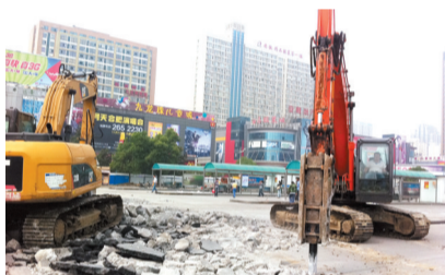
老站台正在拆除
