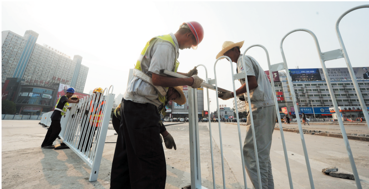
工人正在安装隔离栅栏
