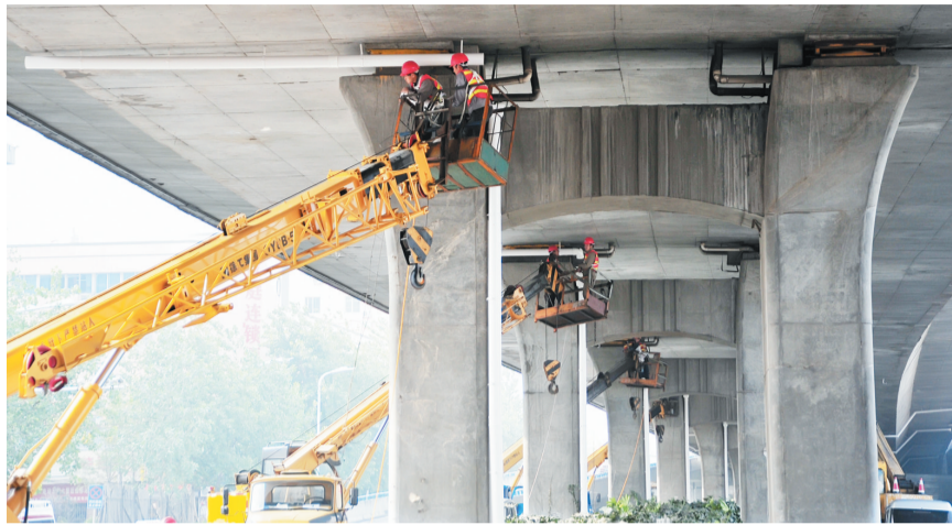
10月22日,合肥市市政工程施工人员正在对金寨路高架进行雨水工程改造。据了解,每逢雨雪天气,金寨路高架下车辆犹如穿行在“水帘洞”中,改造后的雨水管路将桥面积水直接引入花坛中的下水道。
