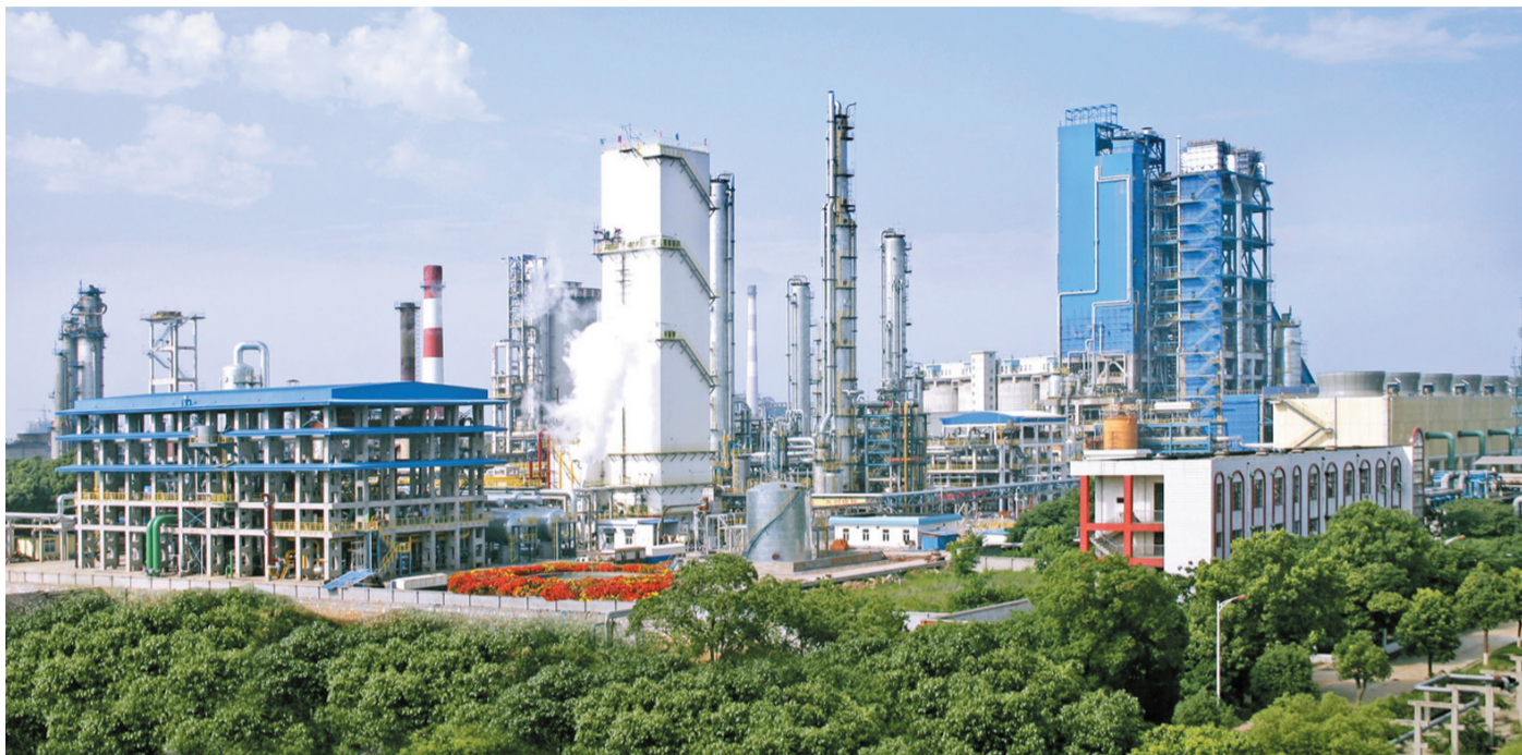
“油改煤”工程全景
