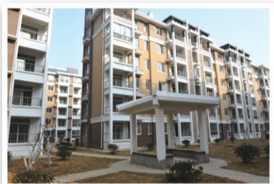
蚌埠市安居工程
