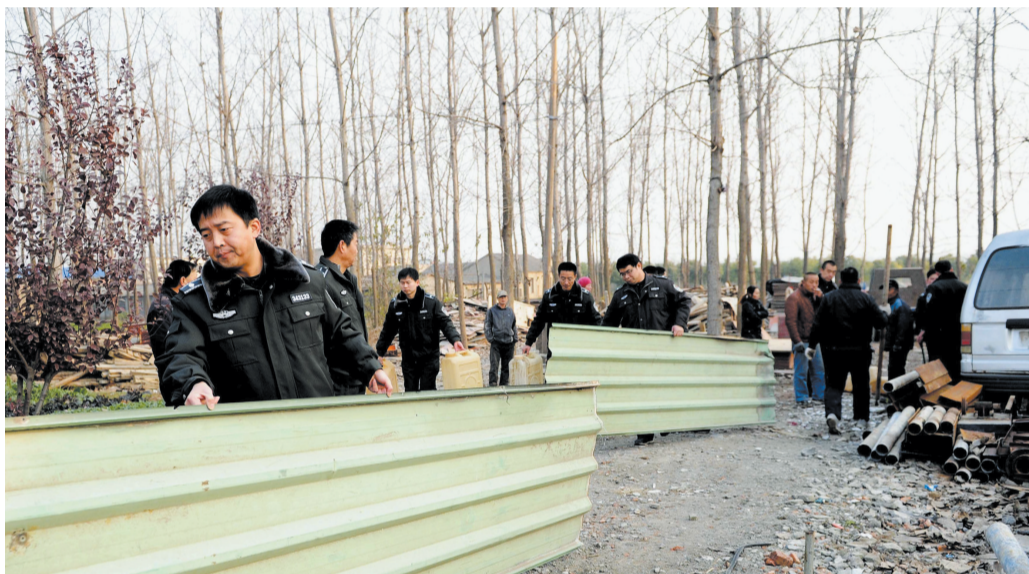
昨日上午,合肥市庐阳区市容部门对合淮路十张村路段临时搭建的摊棚进行拆除,以提升市容环境,靓化出城路口。 郑慧 转红 记者 倪路/图
