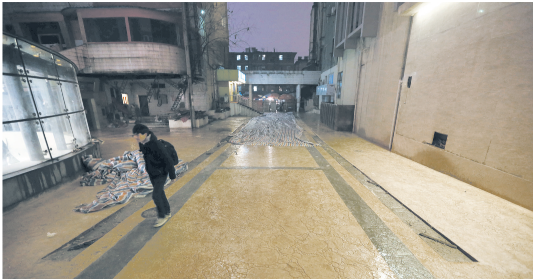
仁和巷地面改造工程已完成过半
