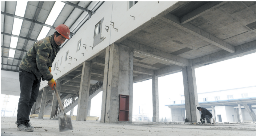
新周谷堆一期工程已基本完工
