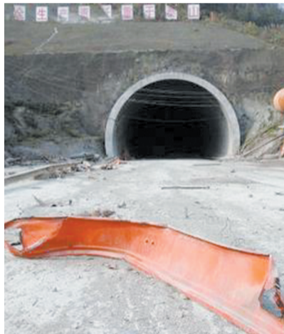
事发在建铁路隧道
