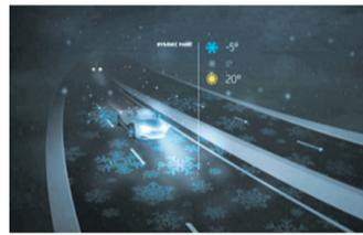
荷兰将拥有“会发光的道路”,它不用路灯也能照明,路面还可提醒人们气温。发光公路的创意由荷兰设计师丹·罗斯加德和海曼斯基础设施管理集团共同提出,并于去年获得荷兰设计奖的最佳未来概念奖。在经过不断的升级和研发后,会发光的荧光粉已能投入实践运用。罗斯加德介绍说:“这种粉末就像我们小时候玩的那种夜光涂料,改造后,它能在白天吸收阳光,待到夜幕降临后在黑暗中发光,可长达10个小时。”
