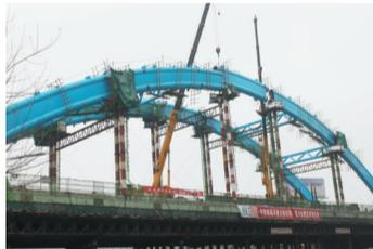
昨日上午11时,由中铁四局四公司合福二分部承建的合福铁路金寨路特大桥,跨金寨路系杆拱上部结构拱桥顺利合龙,这标志着该系杆拱工程整体施工基本完成。
