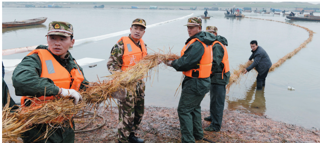
在修水河进鄱阳湖的入口处,武警官兵正在铺设稻草做成的拦油坝
