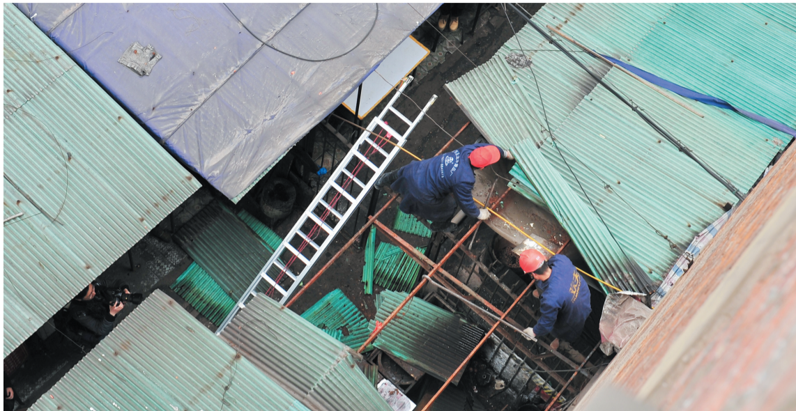
乱搭乱建的雨棚被拆除
