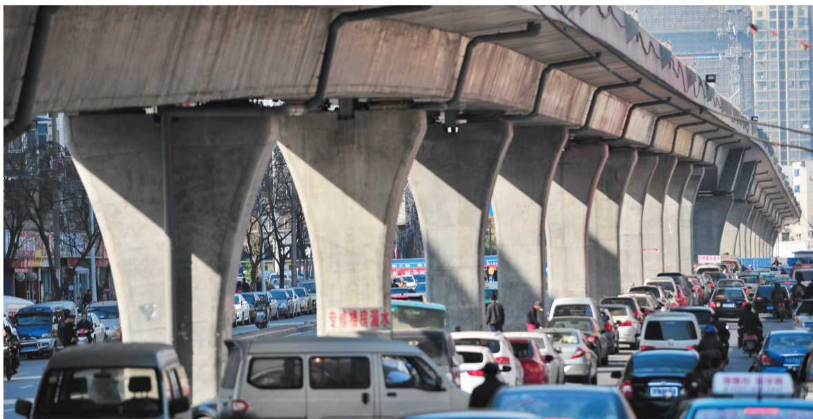
高架桥下车流量非常大
