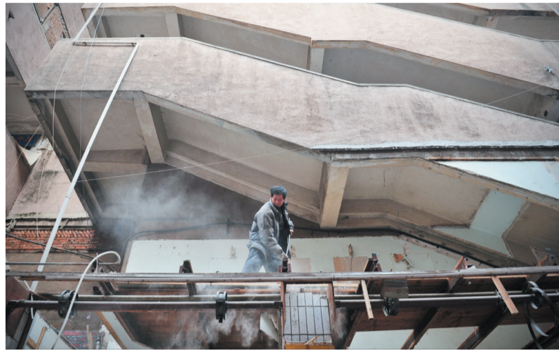
近日,合肥市七桂塘,施工人员正在拆除乱搭乱建房屋。据了解,七桂塘区域目前已实行半封闭施工状态,大面积拆迁工作按原计划进行。 陶广阔 记者 程兆文/图
