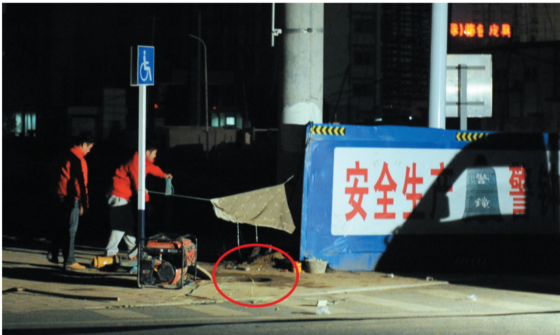
事发窨井旁边放置着大量施工工具
