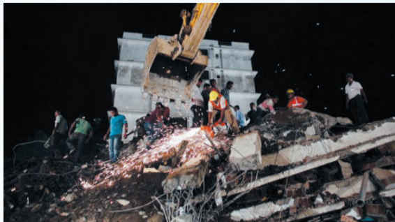
救援人员在大楼倒塌现场搜救
