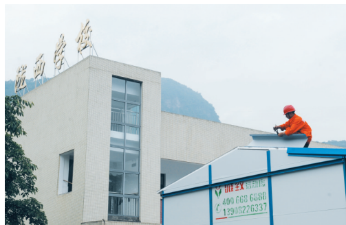
雅安市陇西学校校舍受损严重,正在搭建板房
