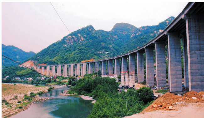
道路桥梁建设
