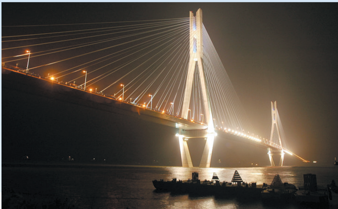
长江大桥建设
