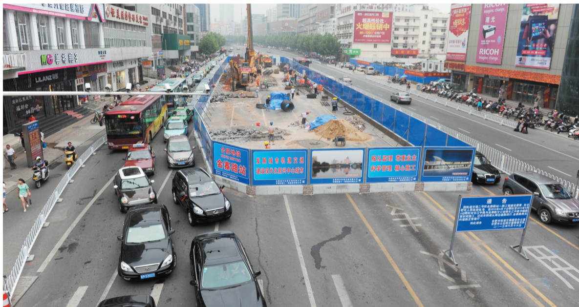
地铁2号线青阳路等7站点封闭施工已满一周,昨日,记者驱车沿金寨路左拐进入长江路后向西行驶,发现长江路的车流量明显减少,长江路周边支路也通行顺畅。但青阳南路、史河路等路段车辆违规掉头现象仍然存在。记者 鲁龙飞/文 黄洋洋/图
