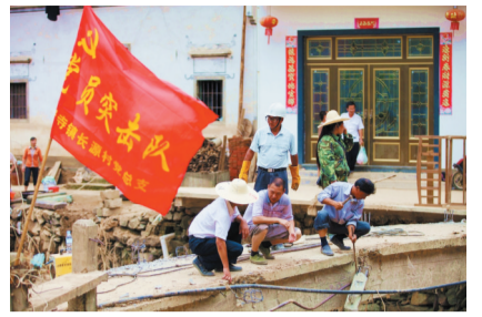
黄山民众抢修被毁桥梁
