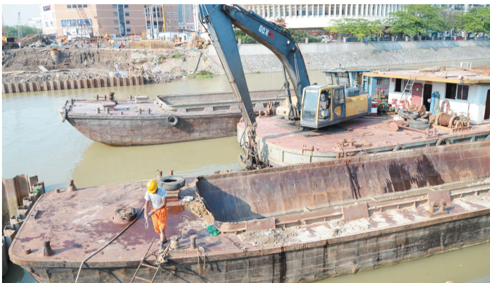
7月8日,合肥地铁一号线长江路桥施工现场,水上挖掘机准备进行作业,现场停靠着前来清理围堰土方的货船。据了解,该桥将在8月1日开始浇筑桥墩。
